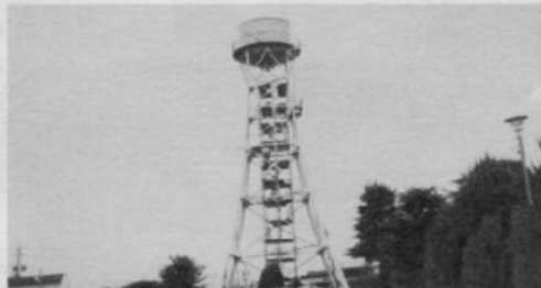
▲撤去前の給水塔
